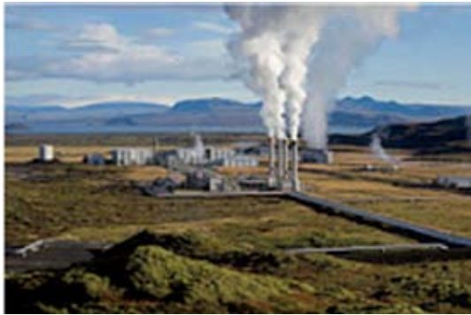
Figura 3 - Usina geotérmica de Nesjavellir na Islândia
